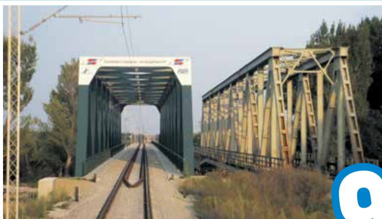
Нови железнички мост на Тамишу
